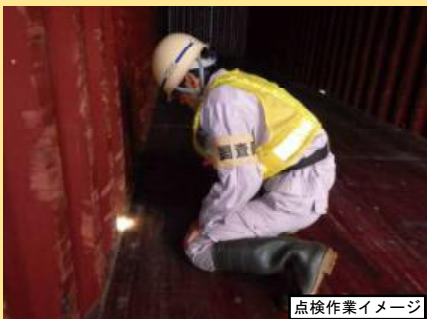
点検作業イメージ
