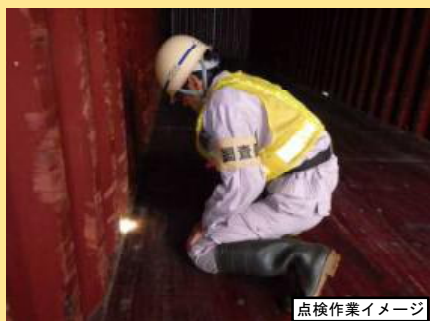
点検作業イメージ
